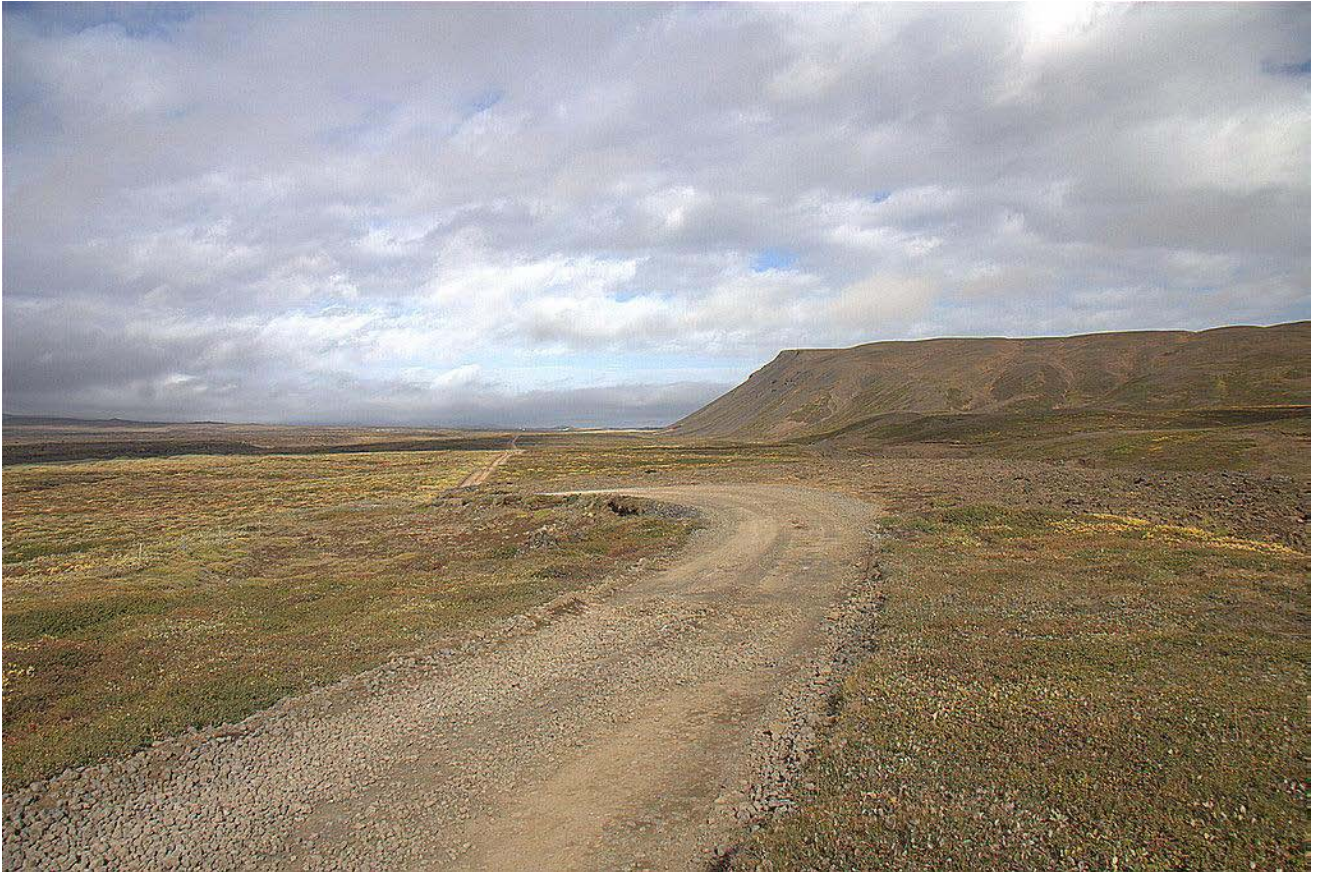
Mynd 2.28 Aðstæður við slóðagerð. Mynd tekin í norður af fyrirhuguðu framkvæmdasvæði vestan Kvihólafjalla.
